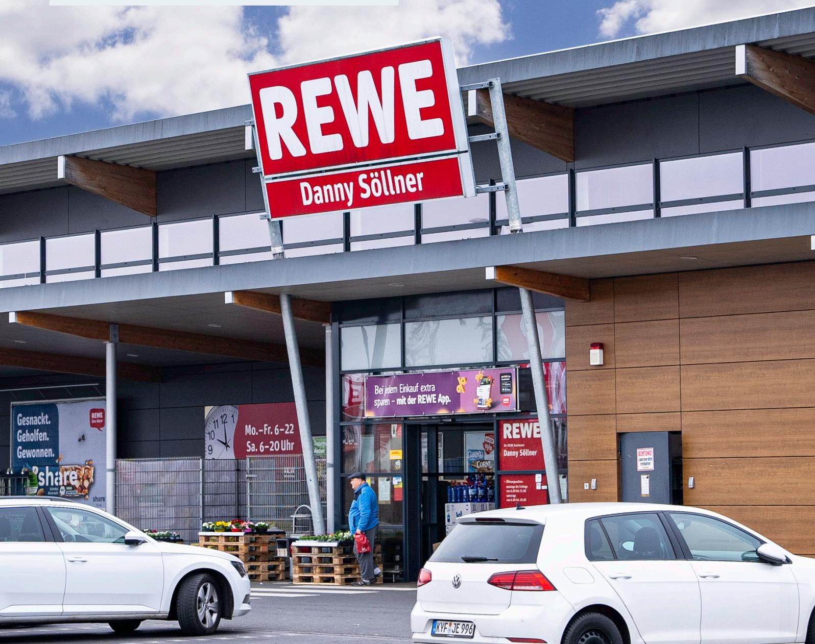
Le bâtiment a été construit en 2013. Les murs sont en maçonnerie et en béton. La structure du toit est constituée de poutres en bois. Elles sont apparentes et de grande portée. L'ensemble comprend un parking de 95 places.
